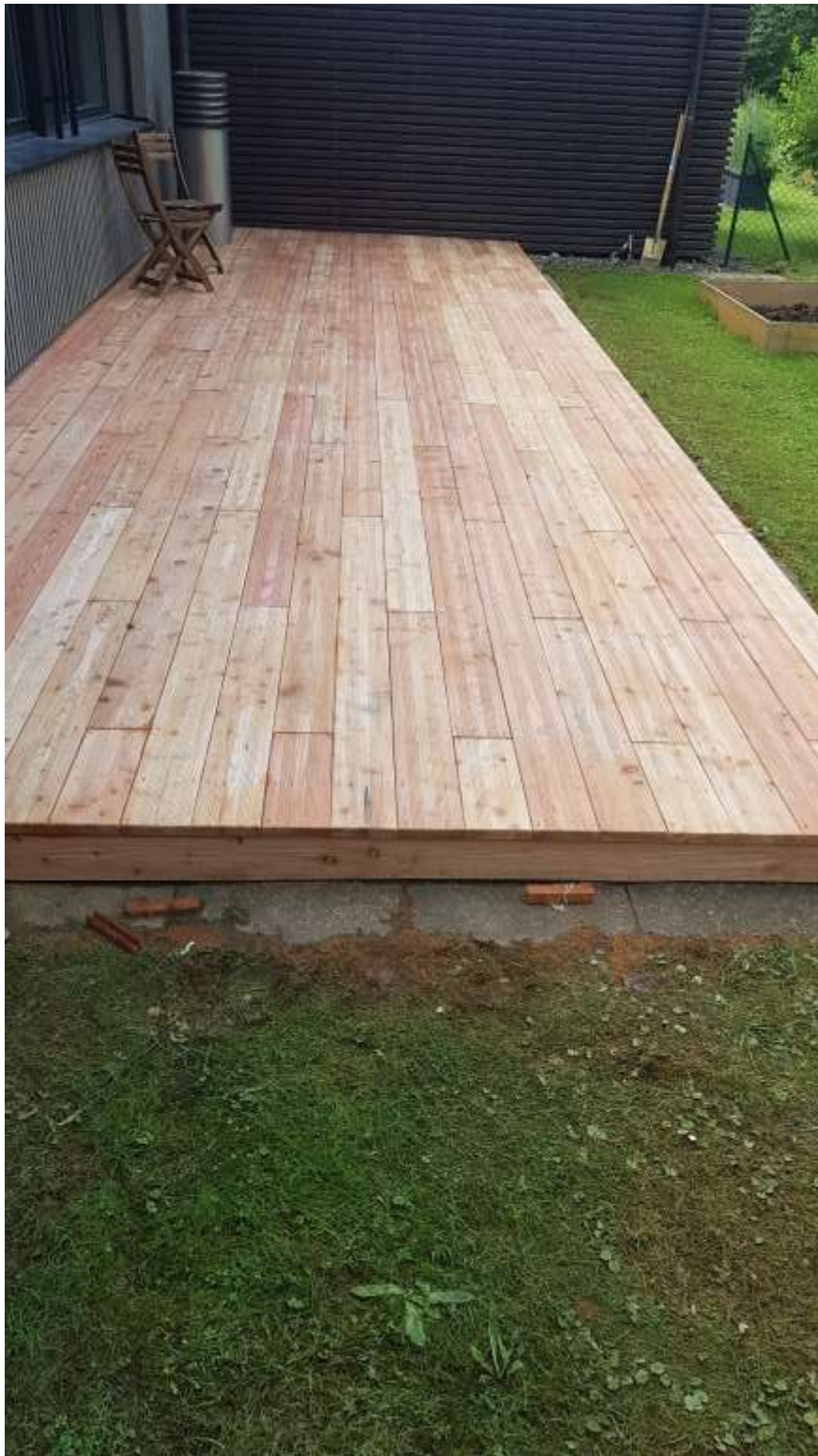
Therrasse mit Lärchenholz auf Plattenlager auf geleiteten Kunststoffstelzen montiert mit Abdeckung vorn und seitlich, in Regensdorf 2021
